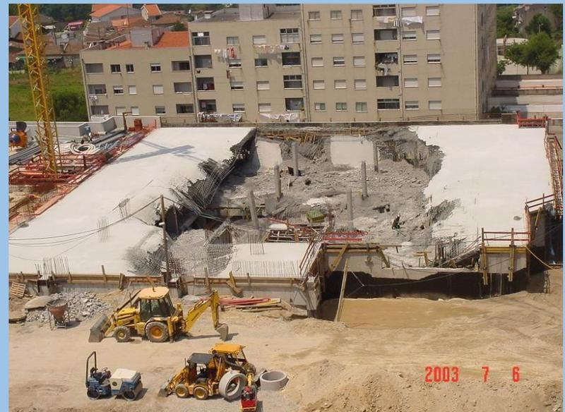
Além da armação de punção, a NBR 6118:2014 estabelece a necessidade de uma armação contra o Colapso Progressivo
